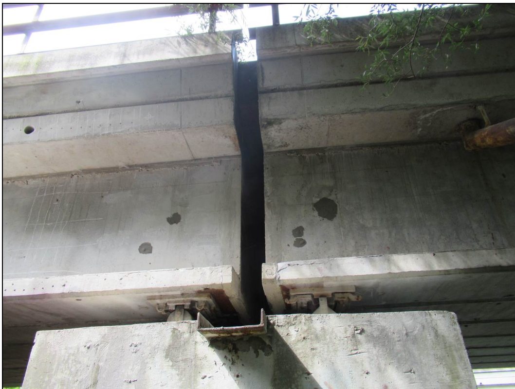
Obr. č. 22 - pohled zprava na bok předepjatých nosníků a na nich nasazenou desku nad pilířem č. 1
