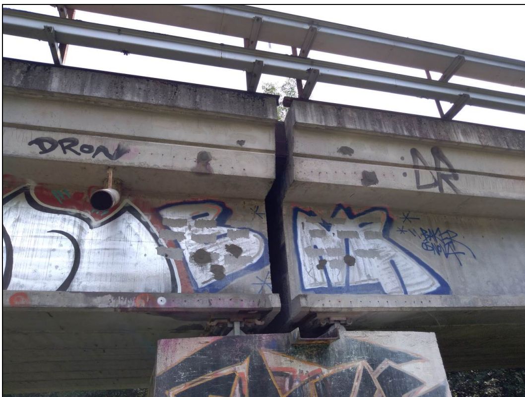
Obr. č. 23 - pohled zleva na bok předepjatých nosníků a na nich nasazenou desku nad pilířem č. 2
