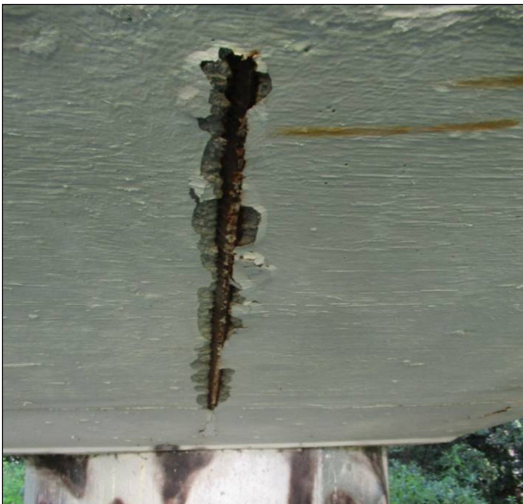
Obr. č. 21 - pohled na spodní lic stativa s odhalenou výztuží zastiženou celoplošnou povrchovou korozí
