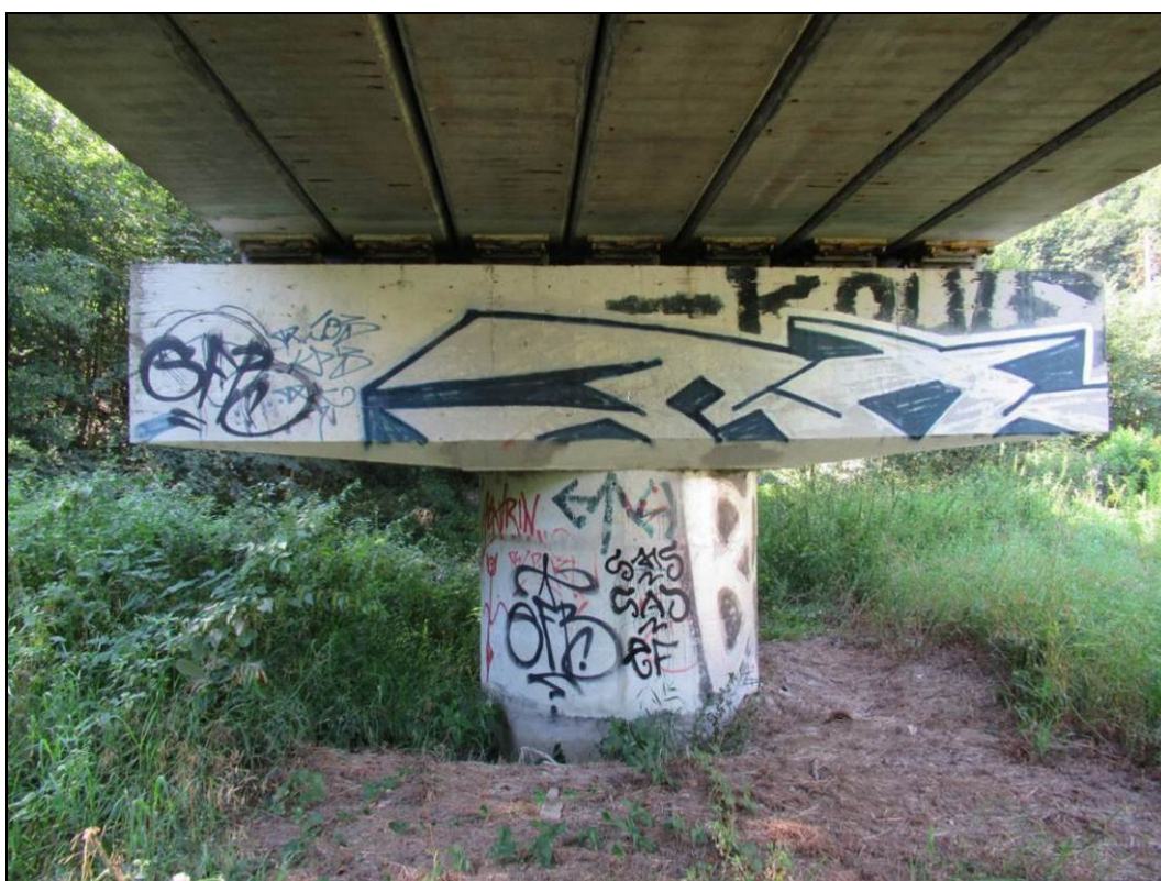
Obr. č. 17 – pohled na pilíř č. 2 tvořený ŽB sloupem a stativem
