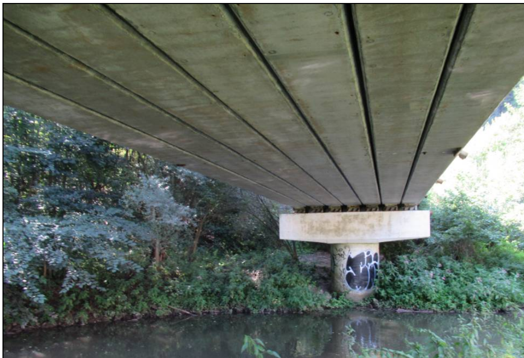
Obr. č. 18 - pohled na spodní líc předepjatých nosníků NK s lokálními projevy koroze smykové výztuže
