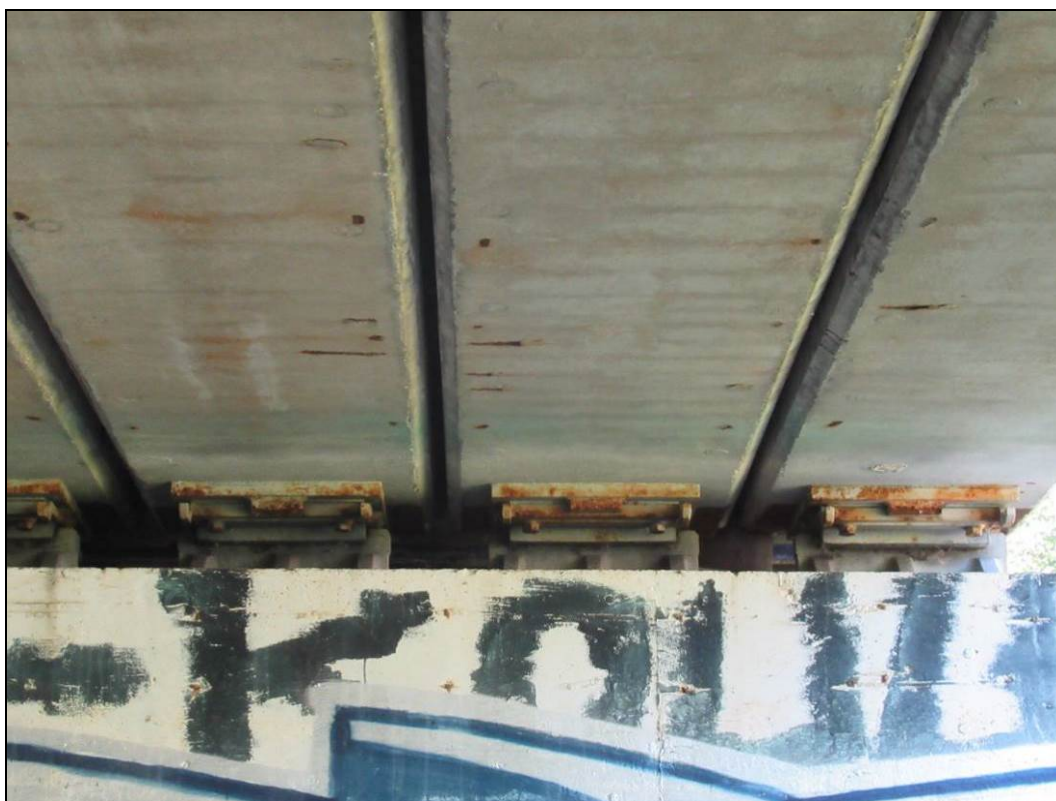
Obr. č. 19 - detailní pohled na mostní ložiska mezi a spodní líc předepjatých nosníků NK s lokálními projevy koroze smykové výztuže
